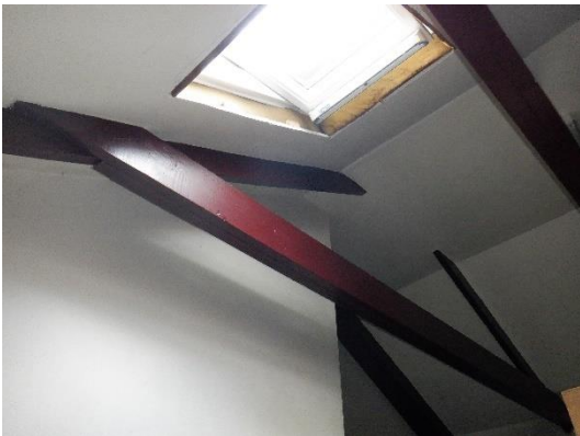
Foto gipsplaat betimmering
